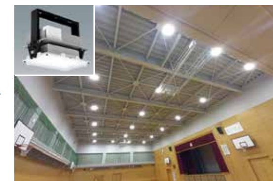
LED水銀灯400Wクラス(消費電力73W)
